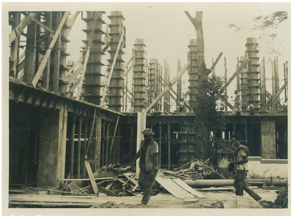
Figura 10: Obras de construção da Ala Frings do Edifício da Amizade. Novembro de 1964. Acervo Núcleo de Memória.
